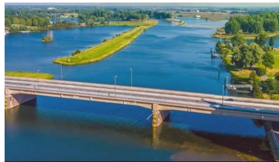
F Louis Ramakers brug - Roermond
