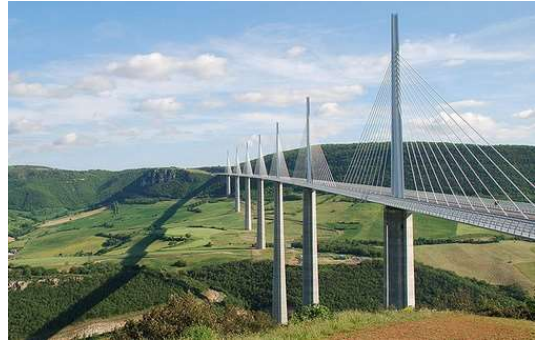
G Milau Viaduct - Milau Frankrijk
